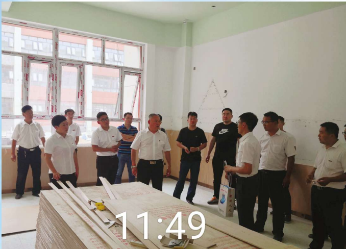
宋伟同志到学校工地现场督促工程进度
